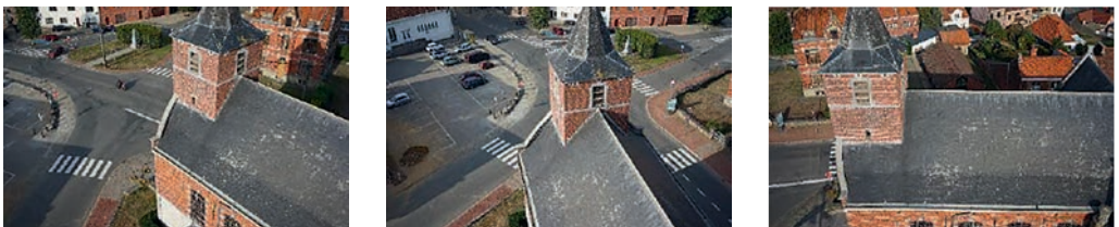
Prises de vues automatiques = séquence pour recouvrement minimum de 60 %.
