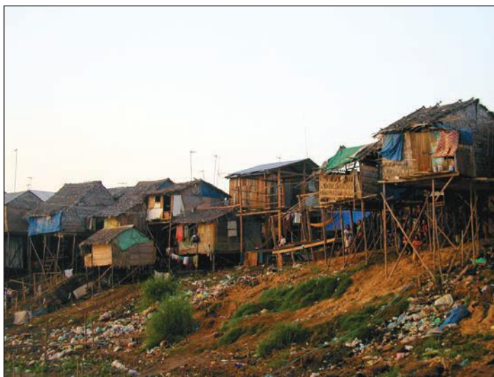
Figure 1.4 Au Vietnam, exemple illustrant les problèmes qui découlent du manque de formalisation du système d'administration territoriale.
