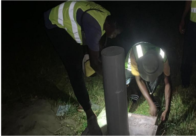
Construction des bornes géodésiques
