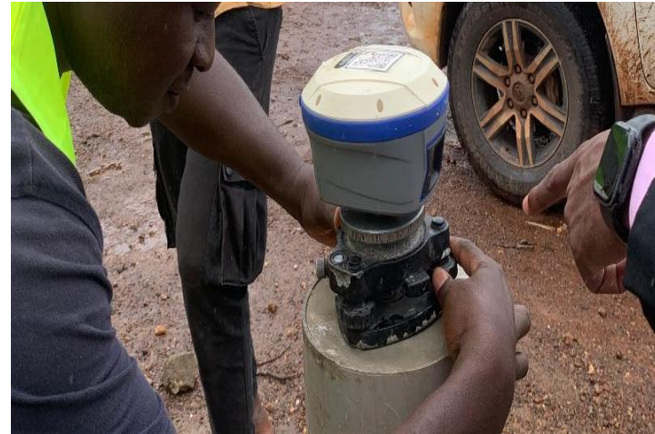
Rattachement des bornes géodésiques
